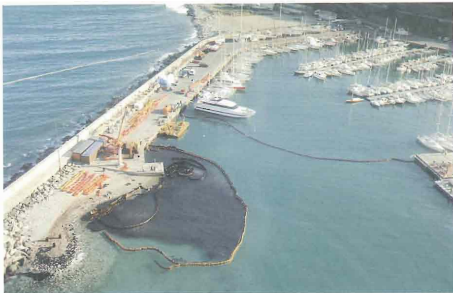
HAVEN - Barrages flottants dans un port de plaisance
