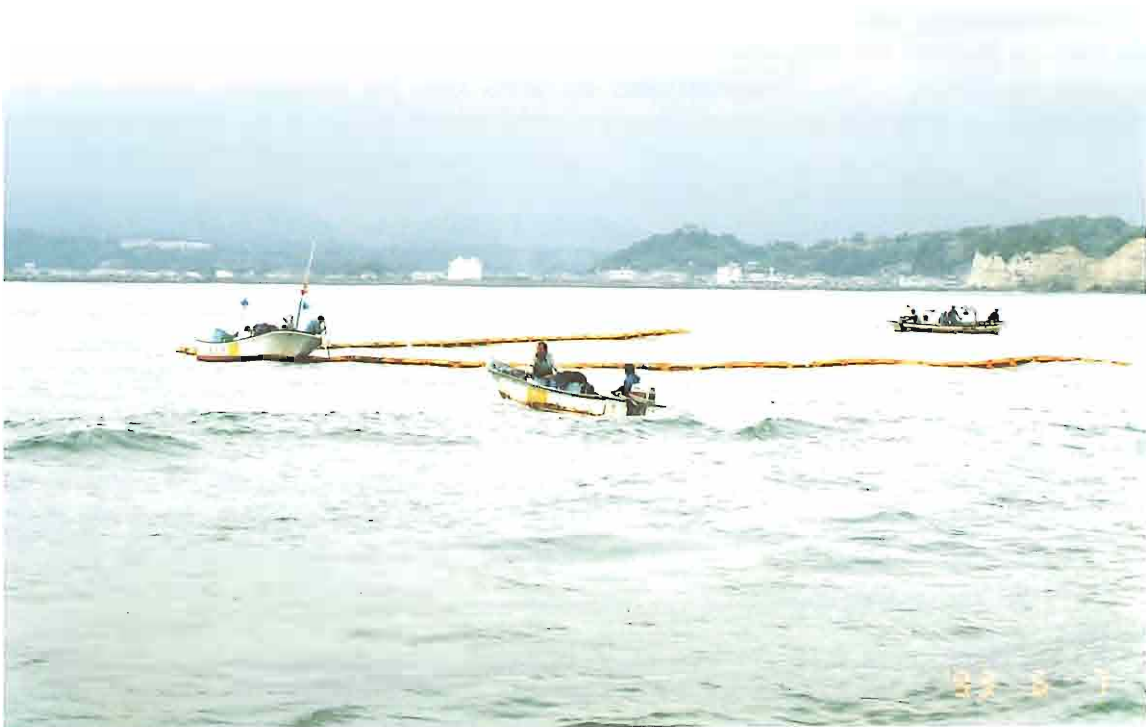
TAIKO MARU - Déploiement de barrages flottants
