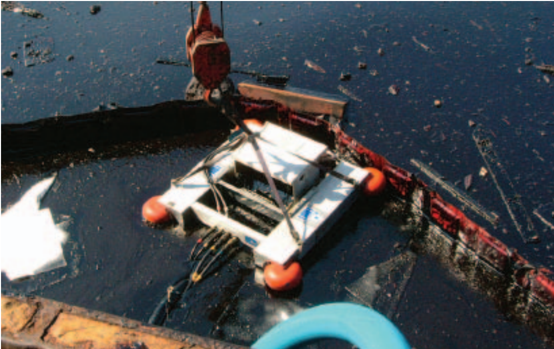
Duck Yang: les déversements d'hydrocarbures dans les ports entraînent invariablement la formation de mélanges d'hydrocarbures et de débris, ce qui augmente le volume des matières à éliminer
