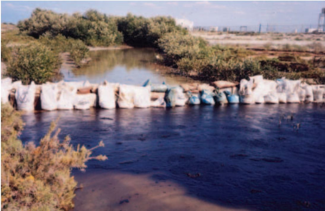
Pontoon 300: une barrière de fortune protège les mangroves des hydrocarbures
