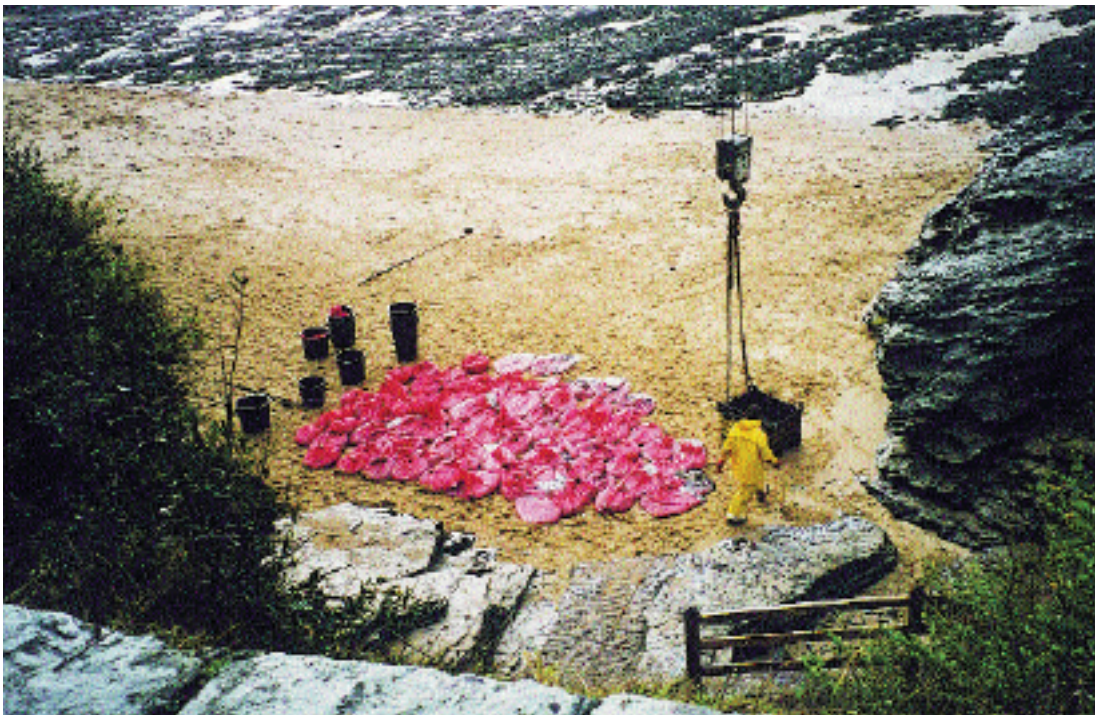
Erika: retirada de los residuos oleosos con grúa
