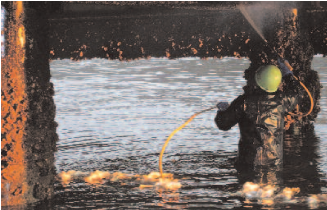
Las operaciones de limpieza a raíz del siniestro del Shosei Maru incluyeron la aplicación de solventes químicos a las instalaciones portuarias contaminadas
