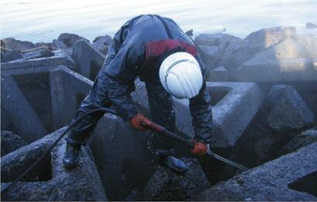
*Shosei Maru: Limpieza del embarcadero mediante mangueras con chorros de agua caliente a alta presión, empleando solventes químicos*
