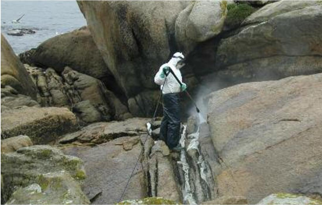
*Prestige: Se limpiaron las orillas rocosas utilizando chorros de agua a alta presión*
