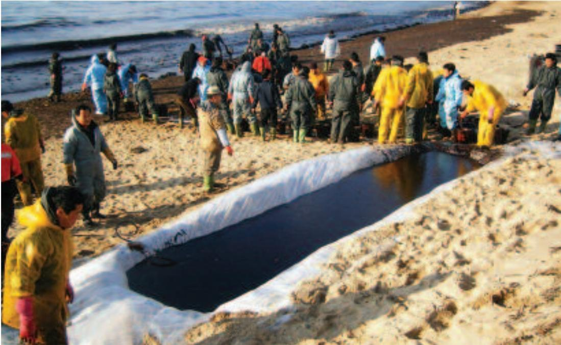
*Hebei Spirit: Almacenamiento temporal de hidrocarburos en un foso revestido por encima de la línea de marea alta*
